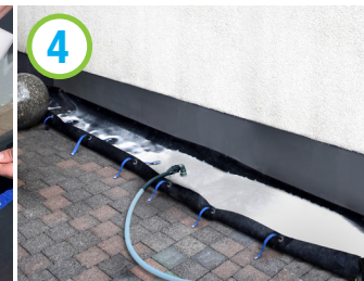
Abpumpen des Schmutzwassers
