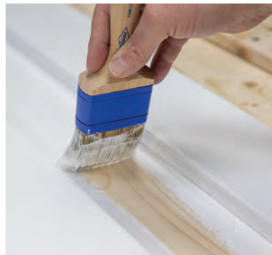
Auf rohem Holz zwei Anstriche. Bei Renovierungsarbeiten reicht in der Regel ein Anstrich aus.
