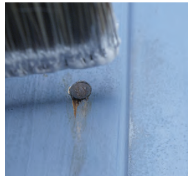
Das Durchschlagen von Rost beim Überstreichen von Schrauben- oder Nagelköpfen wird vermindert.
